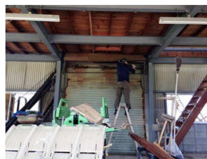
農機具の取り出し中
