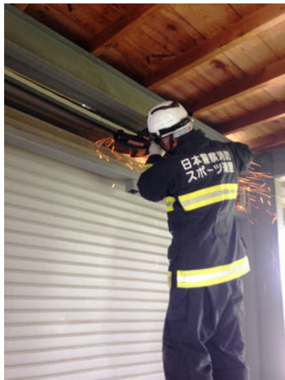
爆風で歪んだシャッターの解体
